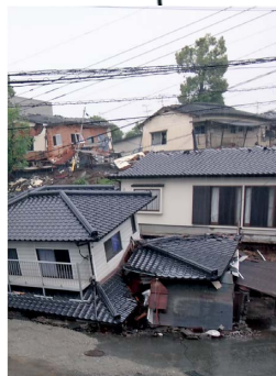
地震による倒壊
